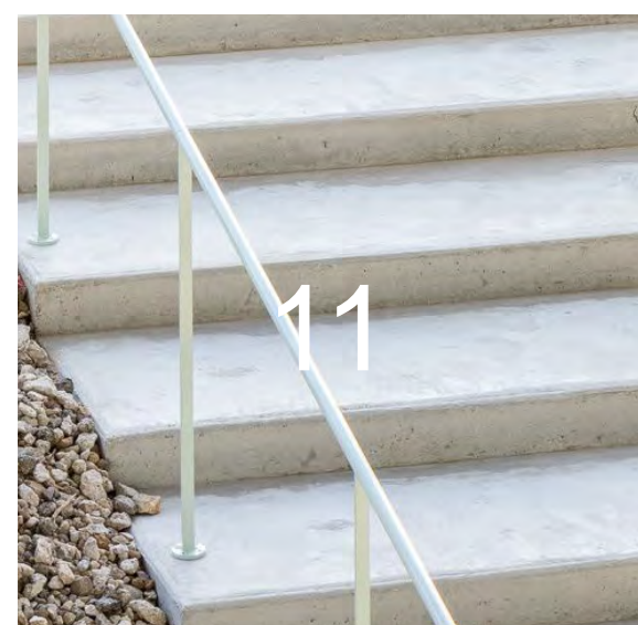
11 betonové stupně, kovové zábradlí
