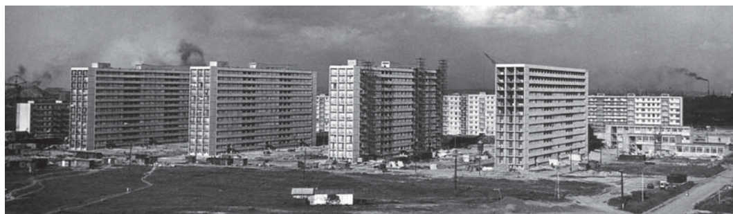
Stavba prototypů G-OS na Bulharské ulici
