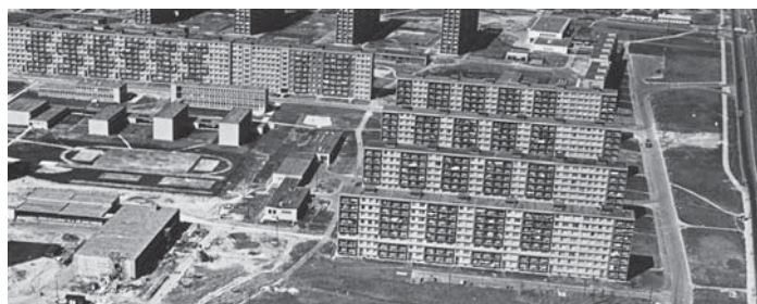
Výstavba na pátém obvodě
