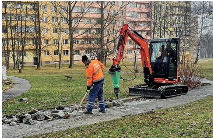
Miniryvadlu se mohou měnit nástavce. Díky tomu může např. rozbíjet beton. Foto: Jana Janošková
