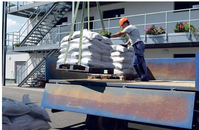
OSM A PŮL | Osm a půl tuny písku bylo rozděleno do tří set pytlů, na deset palet a pak uskladněno k případnému použití. Pytle s pískem jsou připraveny, kdyby jich bylo třeba ke stavbě protipovodňových hrází na toku Porubky. Poruba měla jako jeden z prvních ostravských obvodů zpracován digitální povodňový plán. „Je volně přístupný na www.edpp.cz . V jeho takzvané veřejné části je možné najít veškeré informace týkající se ochrany území před povodněmi,“ uvedla starostka Lucie Baránková Vilamová. Úprava vodního toku podle ní výrazně snížila riziko jeho rozlití – koryto je nyní schopné odvést dvacetiletou vodu. „Tři sta pytlů se může zdát málo. Ale radili jsme se s hasiči a podle nich má smysl, když budeme připraveni, byť budeme mít jen určitou zásobu. Navíc naši zaměstnanci jsou schopni operativně naplnit další pytle. A po regulaci už na Porubce není tolik míst, kde by hrozilo vylítí,“ doplnila. (jan)
