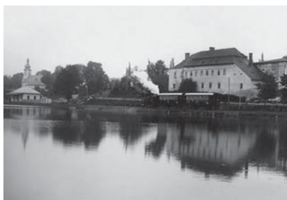
Železniční trať vedla podél rybníka pod zámekem. Foto: archiv ÚMOB Poruba
