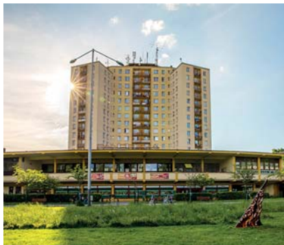
Věžový dům na Havlíčkově náměstí Foto: Jiří Birke
