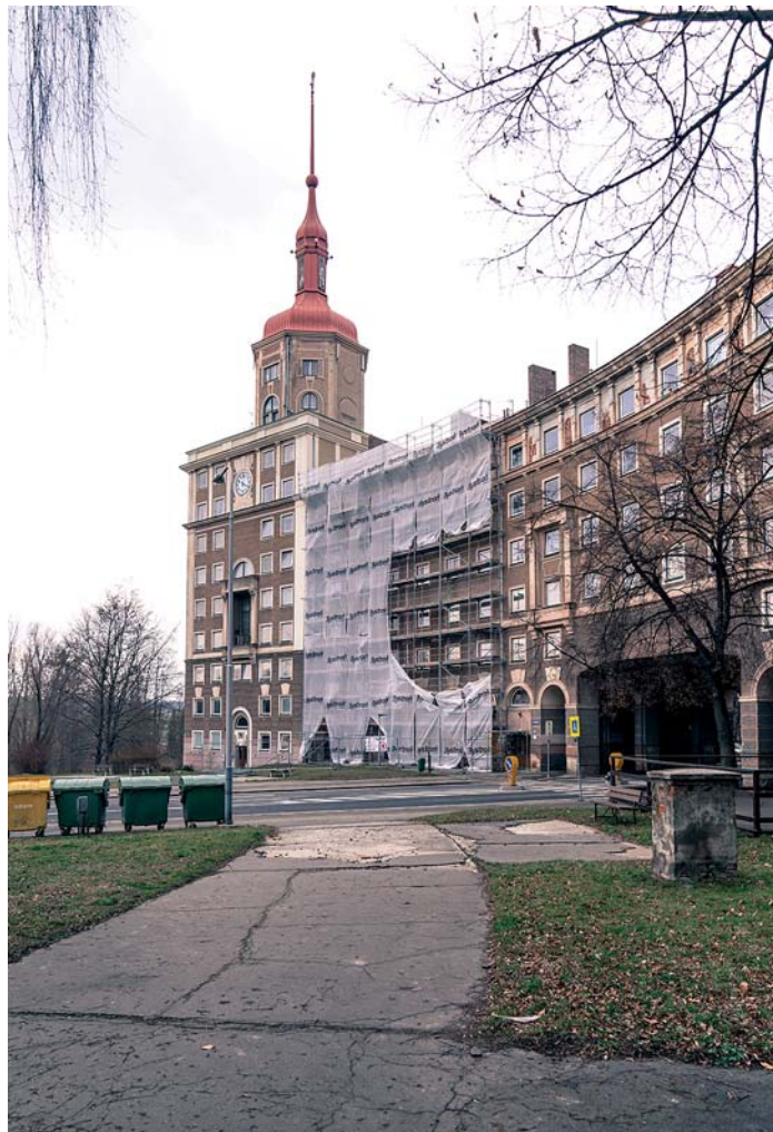
Rekonstrukce objektu začala s prvním březnovým dnem. Foto: Jiří Birke
