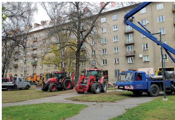
Práce ve dvoře mezi ulicemi Opavskou a Pionýrů Foto: ÚMOB Poruba
