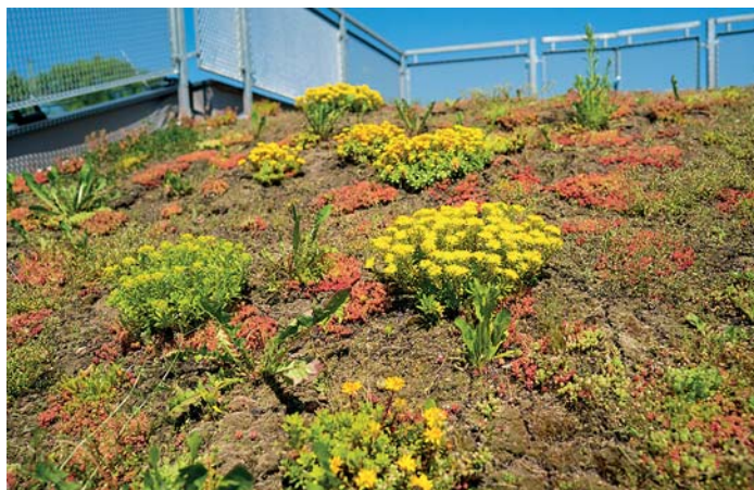
Výhodou zelených střech je mj. tepelná izolace budov. Mají je dvě porubské veřejné budovy: Komunitní centrum Všichni spolu (na snímku) a Dům s pečovatelskou službou Harmonie. Foto: Jiří Birke
