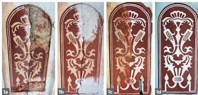
1a – pohled na sgrafita před zahájením prací – trhlina v místě dilatační spáry; 1b – doplnění hrubou podkladovou směsí, dorovnání; 1c – doplnění jemných směsí postupně – intonacco arriccio (červená), intonacco bianco (světlý okr omítka), proškrabání motivu; 1d – pohled po dokončení prací – proškrabání motivu, nátěr intonacca. Snímky: archiv Rest ART
