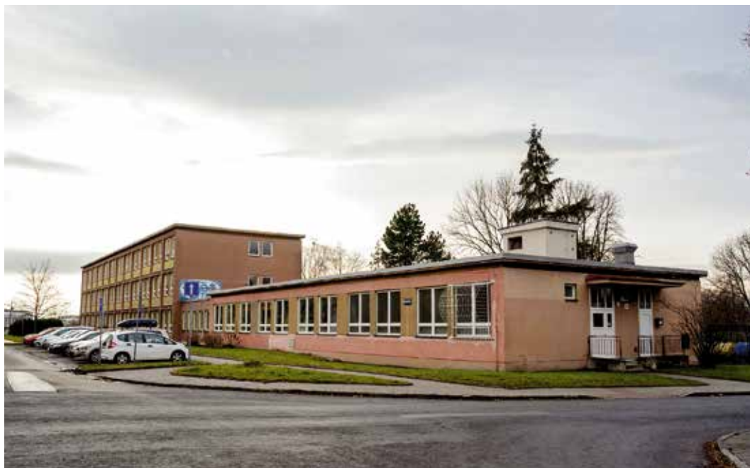
Největší letošní investicí bude oprava budovy waldorfské základní a střední školy
