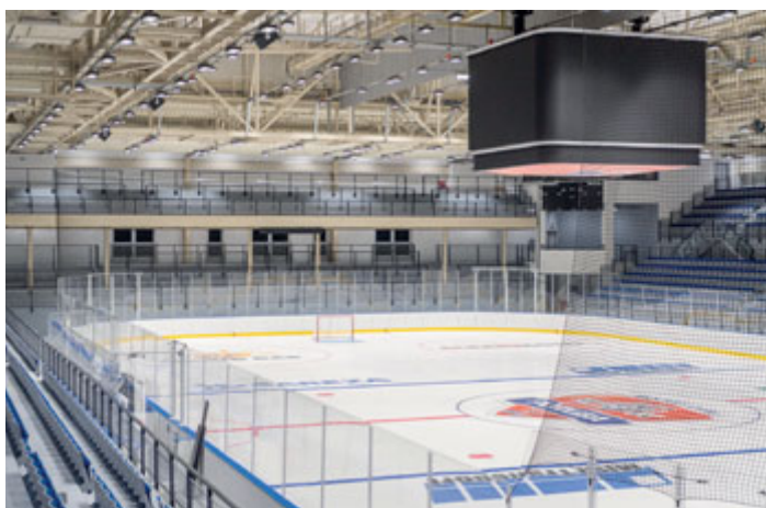
V lednu skončila první etapa rekonstrukce zimního stadionu na Čkalovově ulici, který využívají krasobruslaři, hráči hokejového klubu RT Torax Poruba i veřejnost. Renovace areálu stála přes 75 milionů korun. Pro diváky a fanoušky je v hale nyní asi 2600 komfortnějších míst k sezení, nová je i ledová plocha a technologické zázemí.
