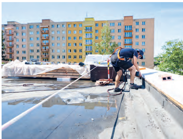
Střecha v Mateřské škole Jana Šoupala získává nový kabát.
