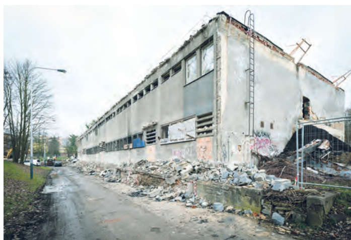
Z ruiny na ulici Mongolská se stává bytový komplex.
