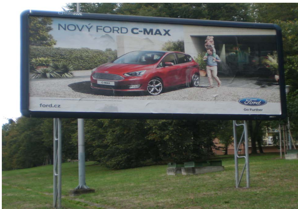
Obr. 14 Billboard trubkové konstrukce – ilustrační foto
