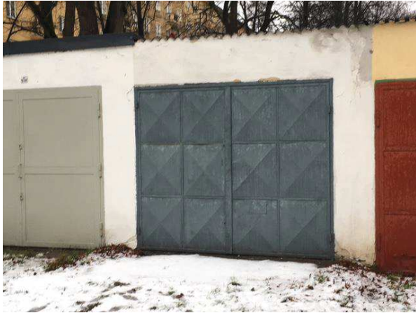
Stavba garáže bez čp/če, stojící na p.p.č. 1462
